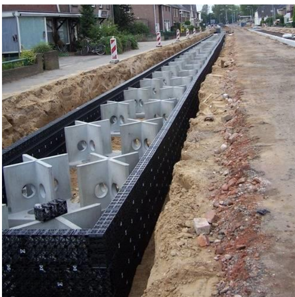
Aanleg van zeer ruime wortelstraat in Nijmegen
