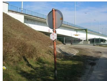
E19/A1 brug over E10-plas
